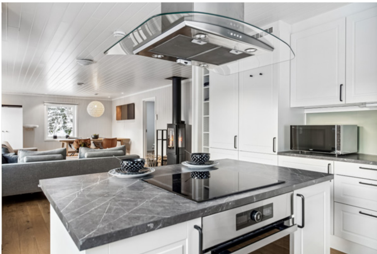
Frittliggende kjøkkenøy med koketopp. Kjøkken ventilator med avtrekk ut.
