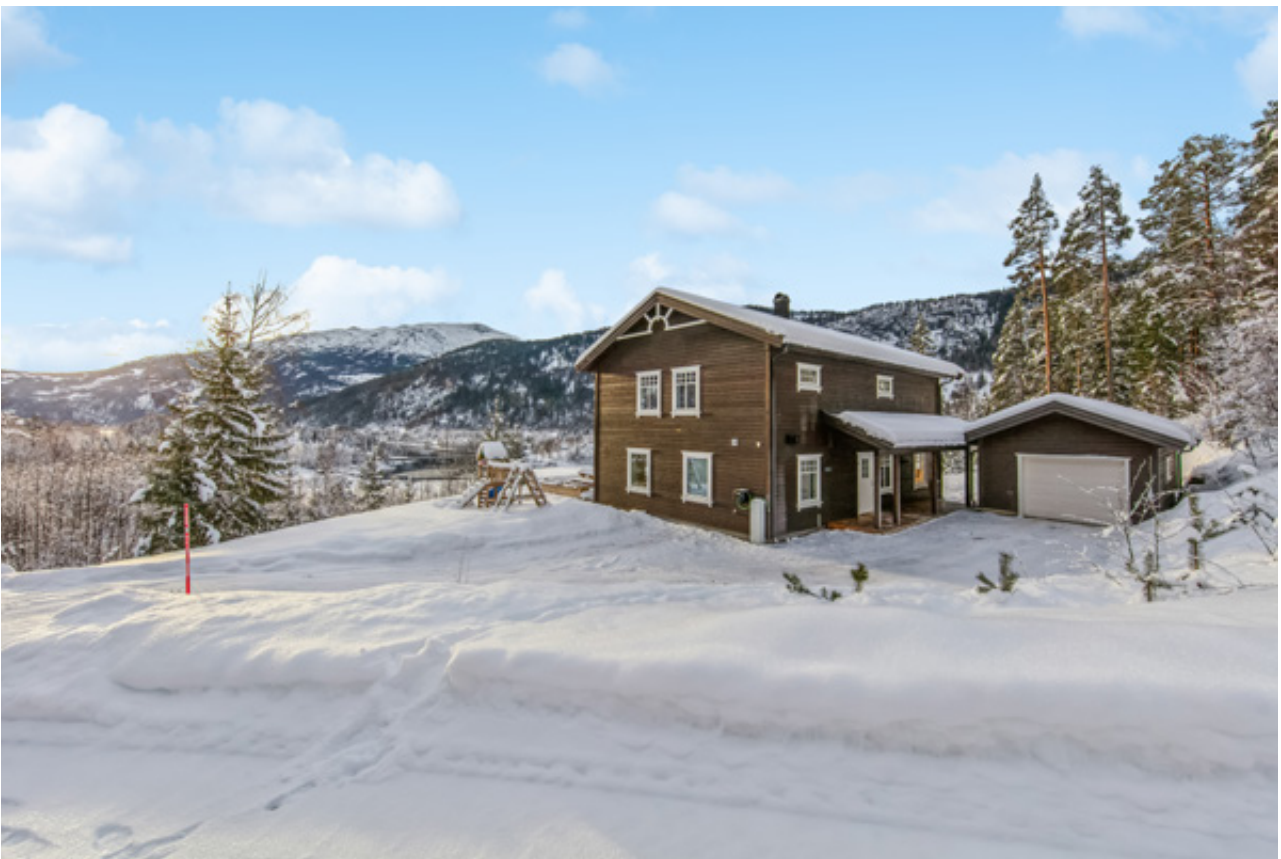
Garasjen har montert lader for elbil.
