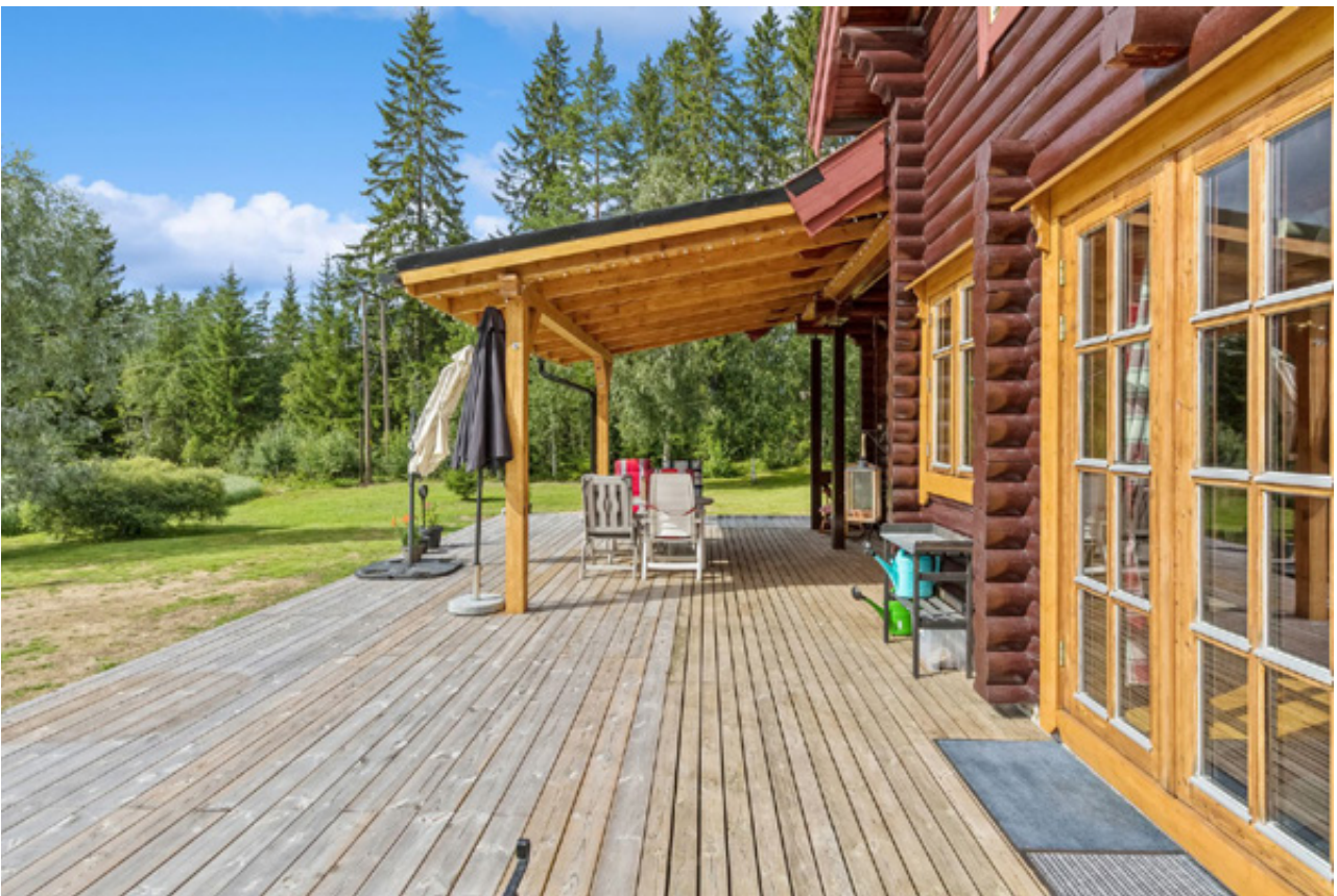
Det er laget nytt takoverbygg til deler av terrassen.
